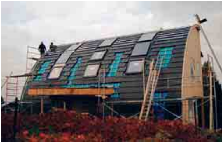
KoraSun kleidakpannen hebben integreerbare zonnepanelen. © koramic
