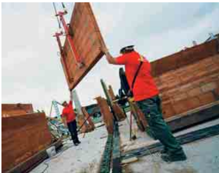
Wienerberger deelt een woning in op maat met prefabmuren. © wienerberger
